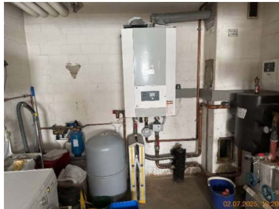
Bild 56: Gas-Heizkessel
