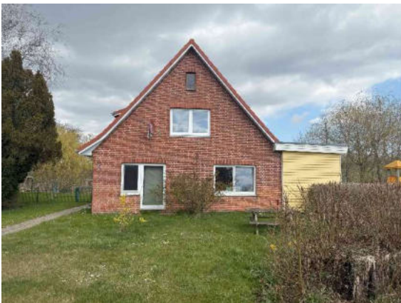
Bild 41: Ansicht von Südwesten
