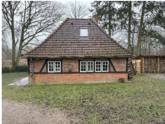
Bild 28: Ansicht von Südwesten
