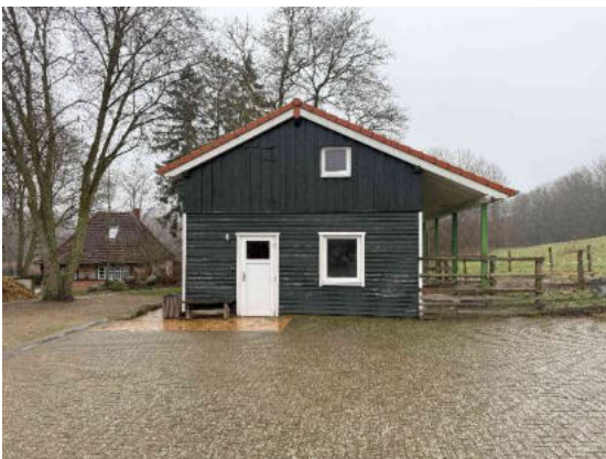
Bild 35: Ansicht von Südwesten
