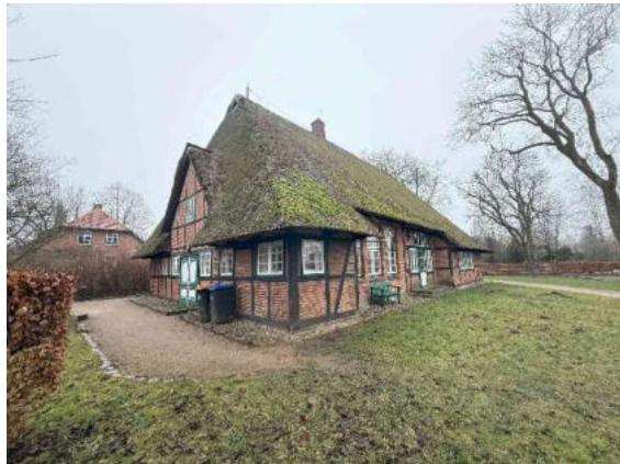
Bild 22: Ansicht von Süden
