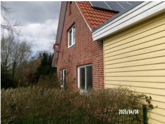
Bild 43: Ansicht von Südwesten
