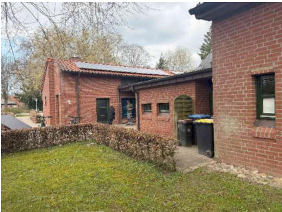
Bild 49: Ansicht von Süden
