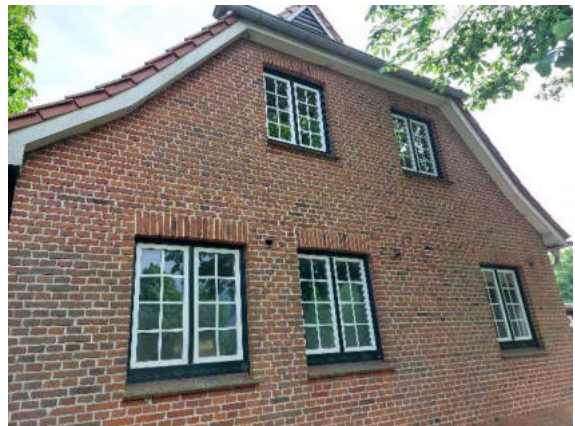
Bild 60: Ansicht von Norden
