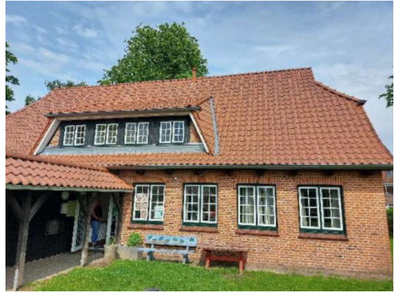
Bild 58: Ansicht von Westen
