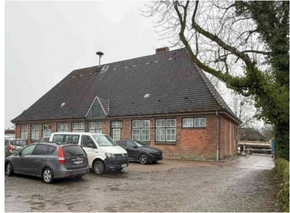
Bild 66: Ansicht von Südwesten
