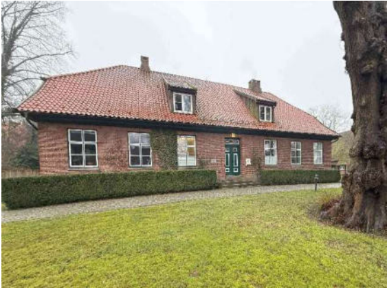
Bild 9: Ansicht von Südwesten
