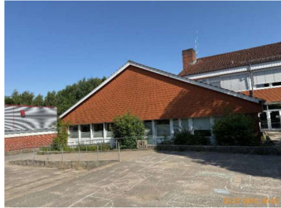
Bild 74: Ansicht von Süden
