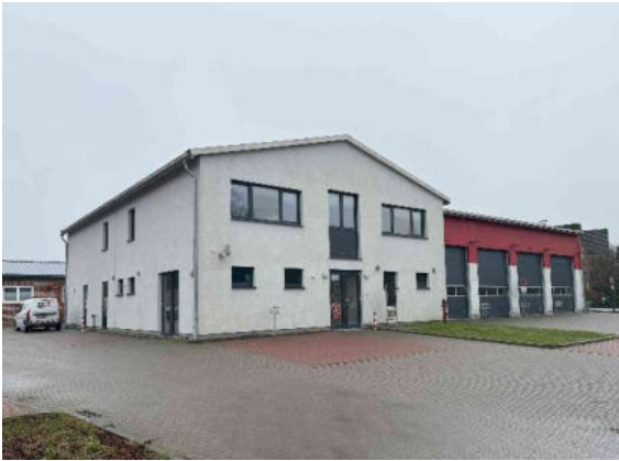
Bild 75: Ansicht von Norden
