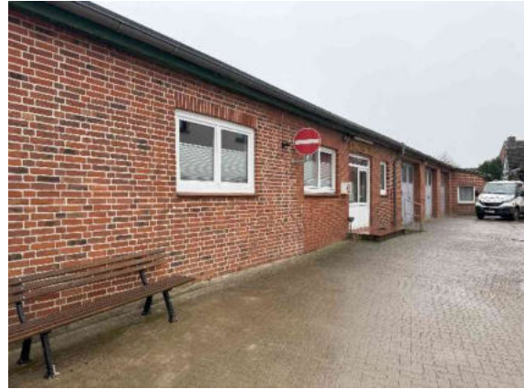
Bild 78: Ansicht von Norden
