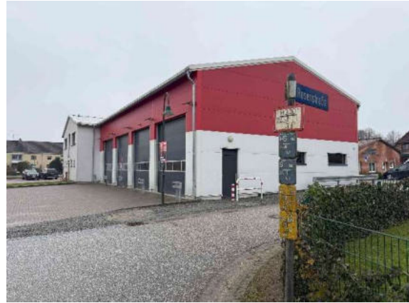
Bild 76: Ansicht von Südwesten
