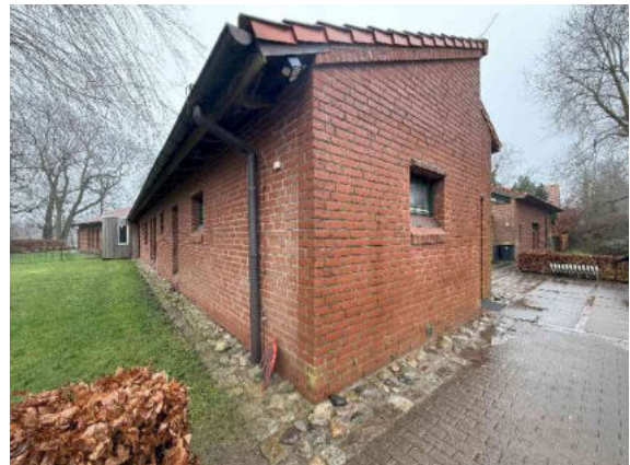
Bild 50: Ansicht von Westen
