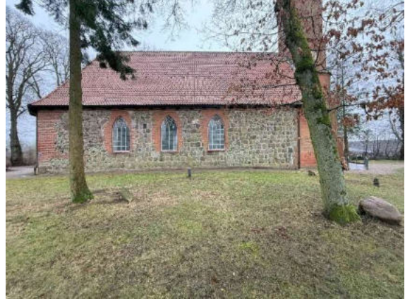
Bild 4: Ansicht von Norden
