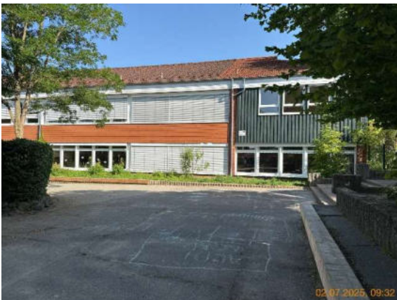
Bild 69: Ansicht von Süden
