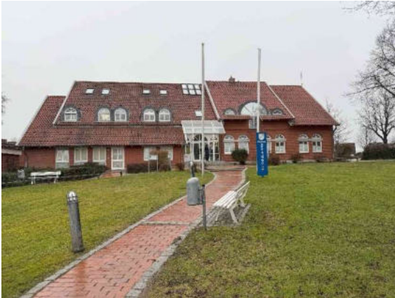
Bild 51: Ansicht von Süden
