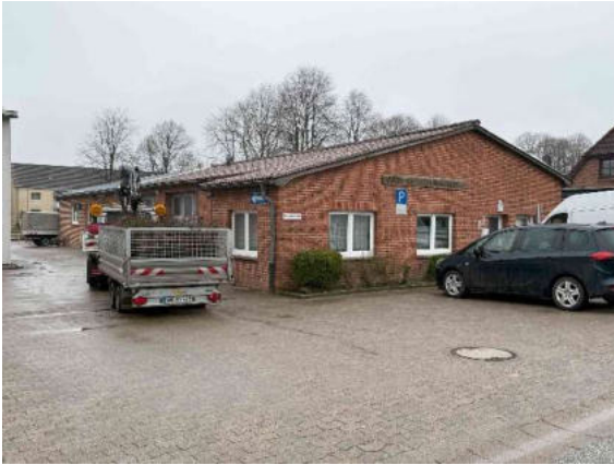
Bild 77: Ansicht von Westen
