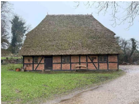
Bild 15: Ansicht von Südwesten
