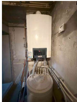
Bild 62: Heizkessel
