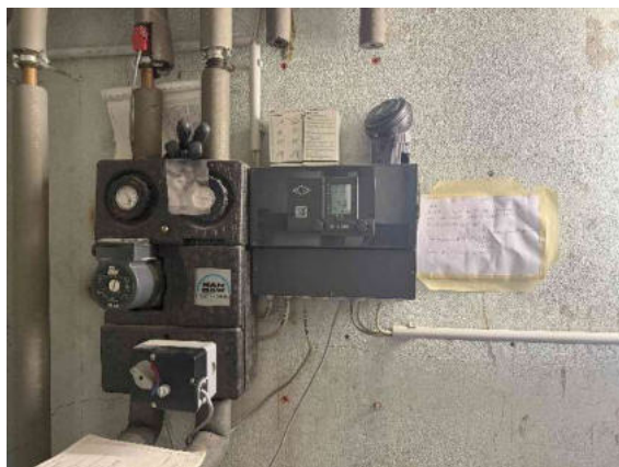
Bild 26: Heizungsregler
