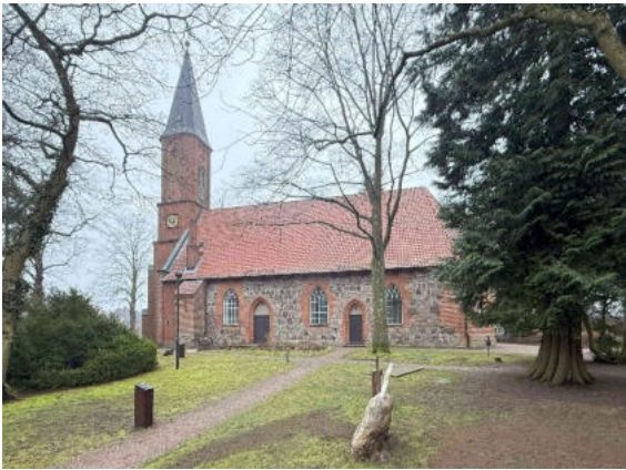
Bild 3: Ansicht von Süden
