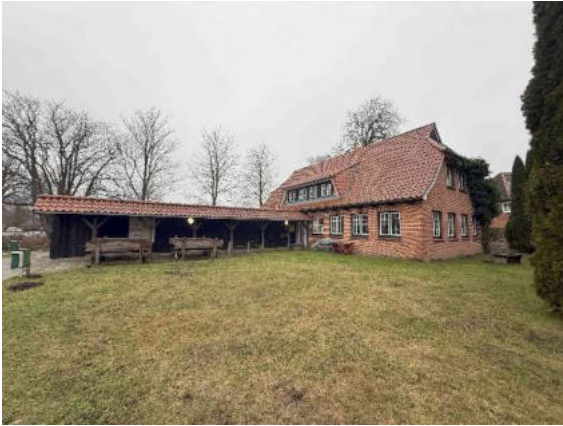
Bild 57: Ansicht von Süden
