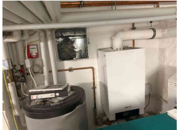
Bild 14: Gas-Brennwert-Wandgerät
