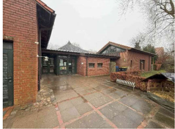
Bild 46: Ansicht von Westen
