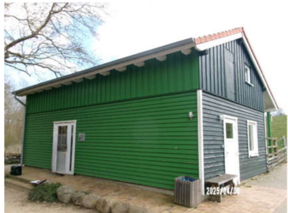
Bild 36: Ansicht von Süden
