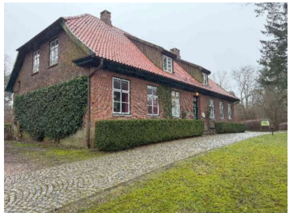
Bild 12: Ansicht von Westen
