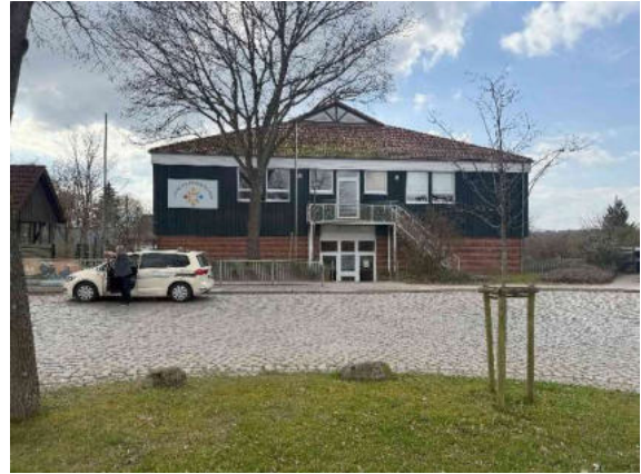
Bild 68: Ansicht von Osten
